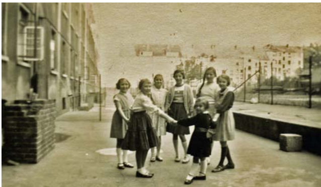
Die durchgehenden Höfe; links sieht man noch den Luftdruck- und Splitterschutz vor den Keller-Hof-Eingängen. Es dürfte sich um Haus Nr. 11A handeln 9 .
